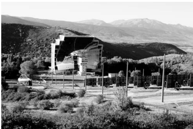
Slika 1: Pogled na sončni center Font Romeu. Veliko poslopje višine 40 m, ki je prekrito z zrcali, prejema sončno svetlobo, ki jo odbijajo zrcala, nameščena na južnem pobočju.
