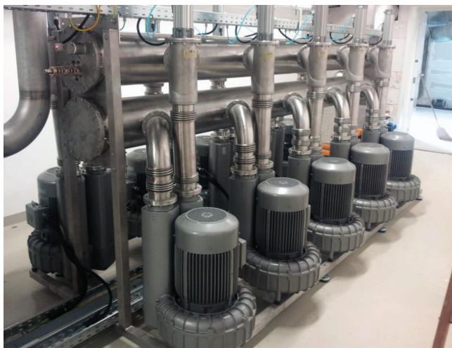
Slika 3: Vakuumsko črpališče NOTOL, Krka, Novo mesto. Črpališče je del centralnega vakuumskega sistema za 16 pakirnih linij v proizvodnji zdravil.
